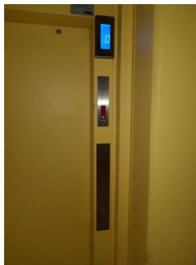
Commande palière du niveau principal
