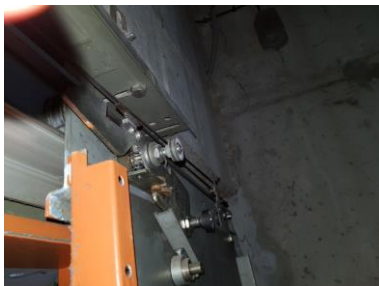
Serrure de porte palière du niveau principal
